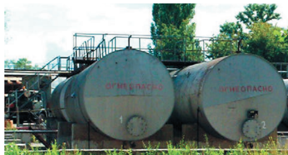
Рис. 1. Сельская автозаправочная станция
